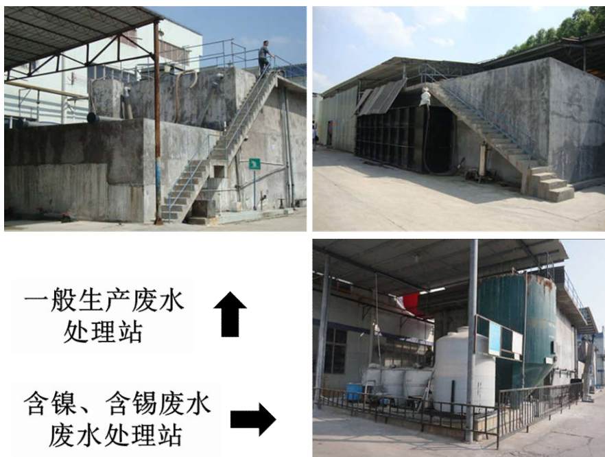
图 2-7 污水处理站现场情况
